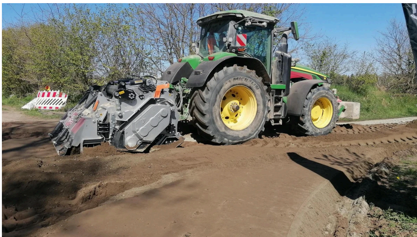
Die Feinbrecherfräse zertrümmert auch Feldsteine direkt auf dem Feldweg zu nur 20 Millimeter kleinem und noch kleinerem Korn. © HA | Susanne Tamm
